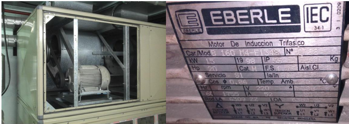
FIGURA 6.2: Foto motor Original / Dados de Placa
